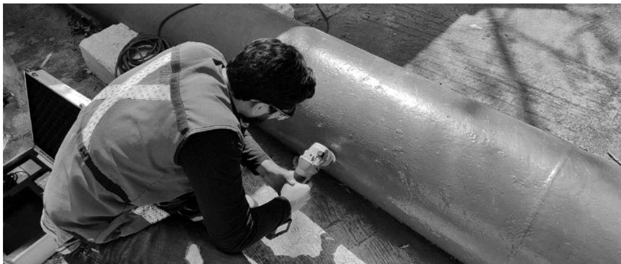
Figura 9. Limpieza de pintura de la tubería con una carda.
