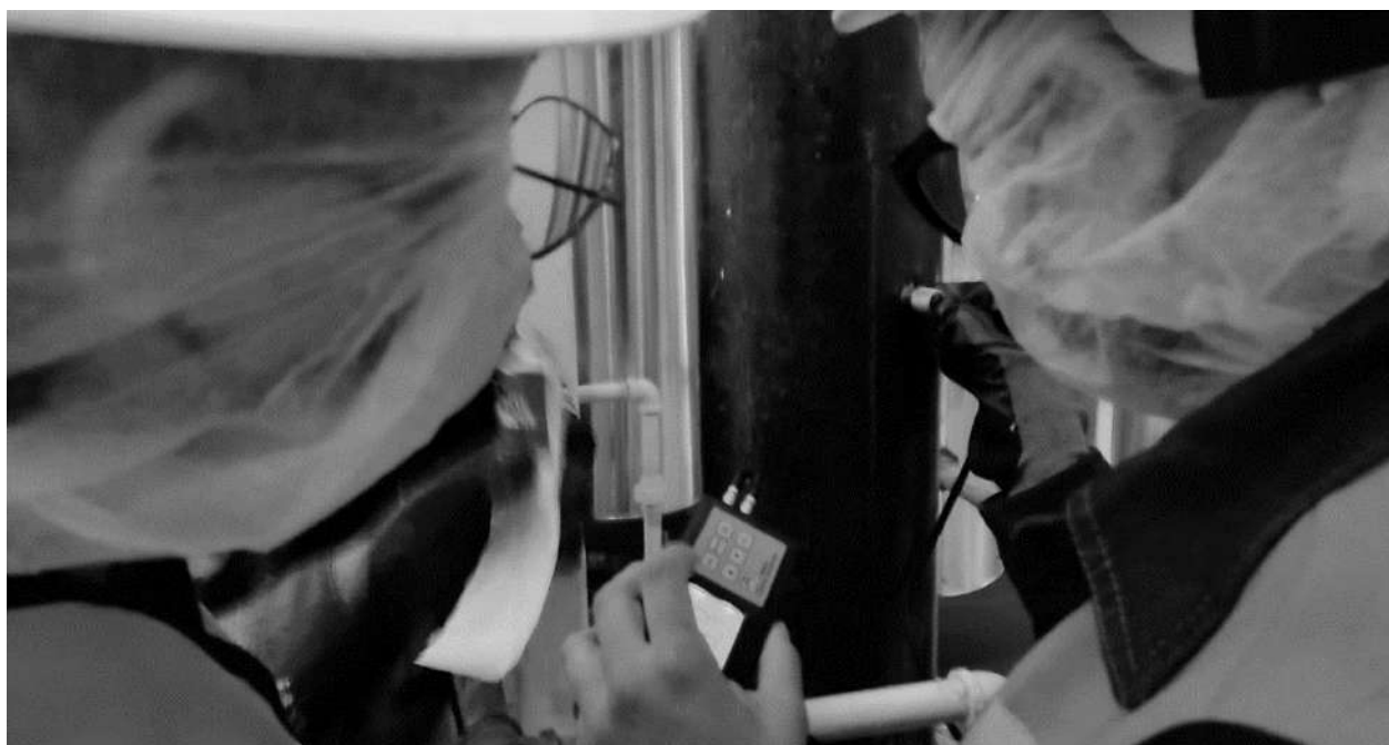
Figura 10. Medición del grosor de la tubería con medidor de grosor por ultrasonido.
